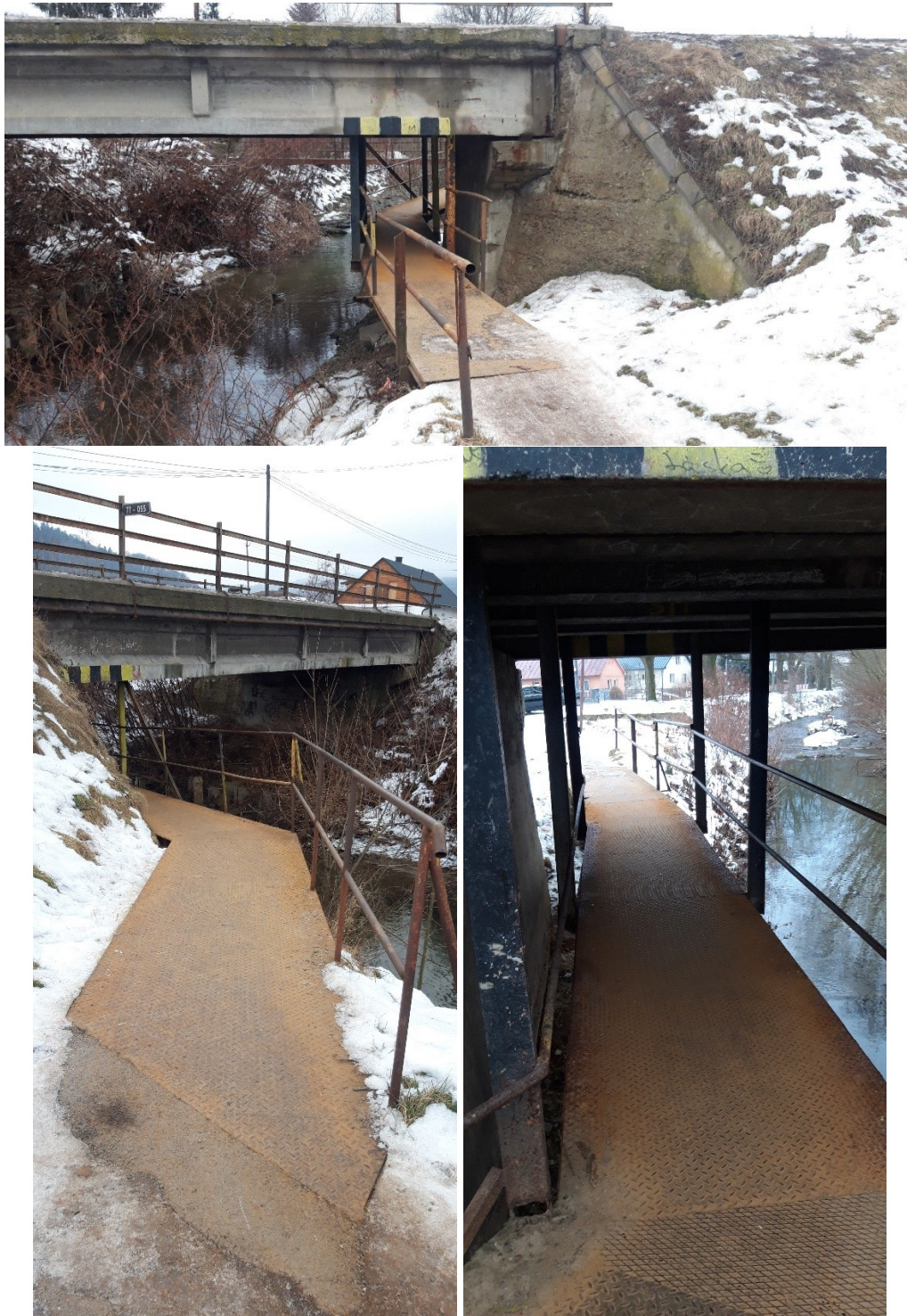
C 1: zavesená lávka pre peších na ceste I/77 pri školskom areáli
