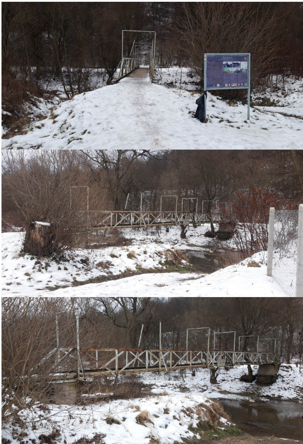
B 1: lávka pre peších pri čističke odpadových vôd
